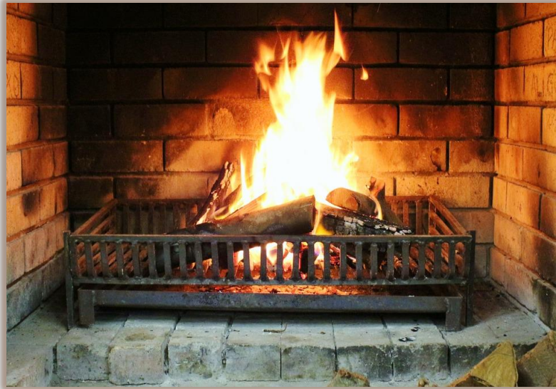
PAR 445 Wood-Burning Devices
